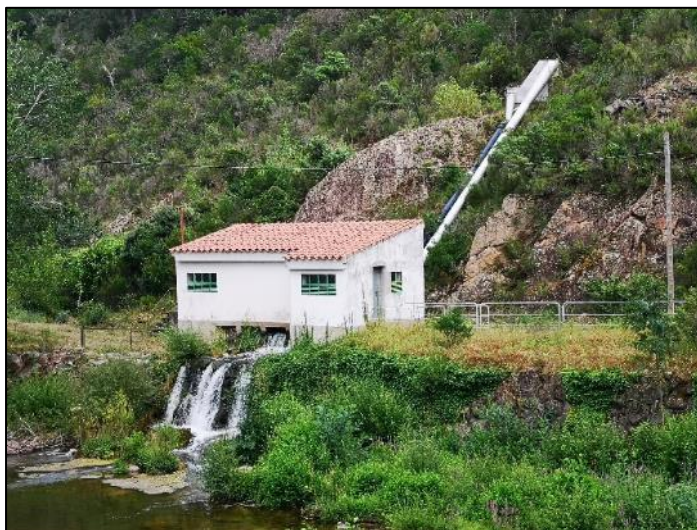
Imatge 3. Trencament de càrrega i sobrelevació.
